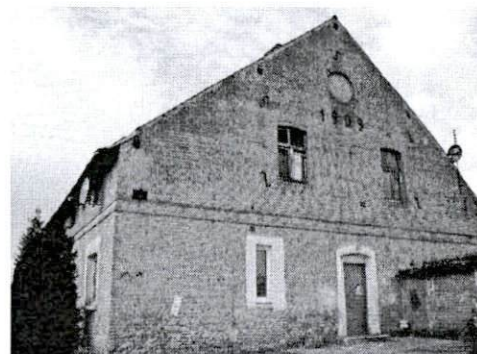
Czworak od strony południowo-wschodniej
