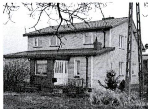
Dom od strony połudnowej
