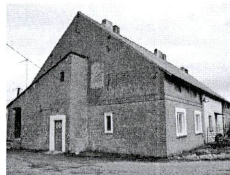
Czworak od strony południowo-zachodniej
