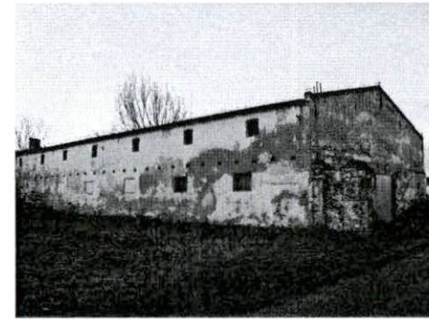
Chlew od strony północno- zachodniej
