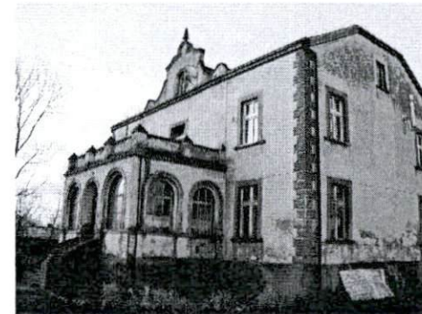
Dwór od strony północno-wschodniej
