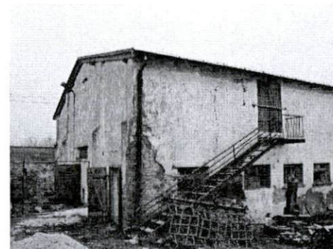
Stajnia od strony południowej
