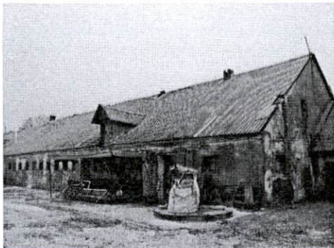
Stodoła od strony południowo-zachodniej
