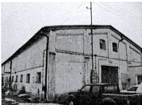
Stajnia od strony południowo-wschodniej
