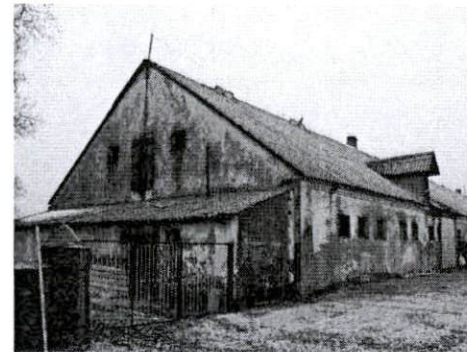
Stodoła od strony północno-zachodniej
