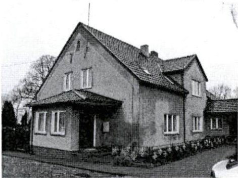
Dom od strony południowo-wschodniej
