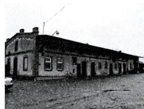
Stodoła od strony południowo-zachodniej
