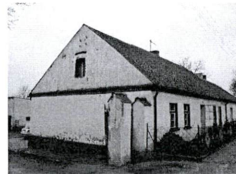
Dom od strony południowo-wschodniej
