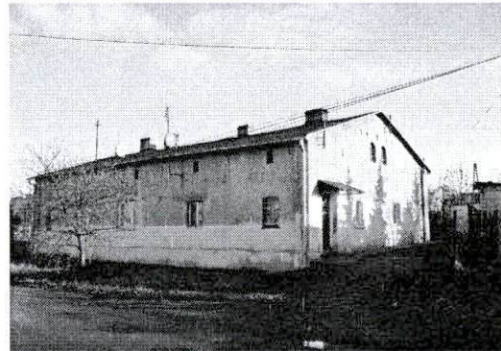
Czworak od strony południowo-zachodniej
