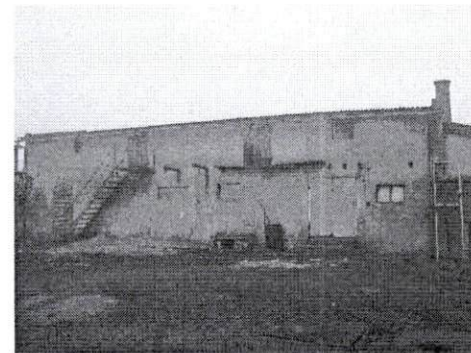
Budynek gospodarczy od strony południowej
