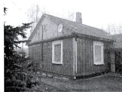
Dom od strony południowo-wschodniej
