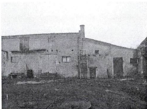
Budynek gospodarczy od strony południowej
