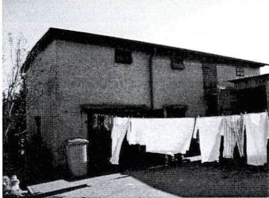
Budynek od strony północno-zachodniej
