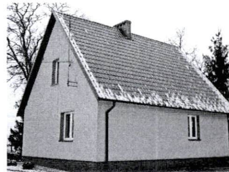
Dom od strony południowo-wschodniej
