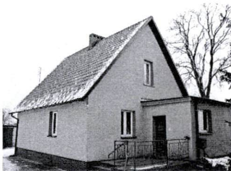
Dom od strony północno-wschodnia
