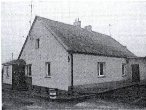
Dom od strony południowo-wschodniej
