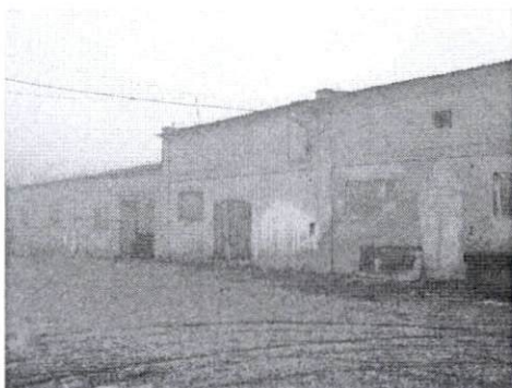
Chlew od strony południowo-wschodniej
