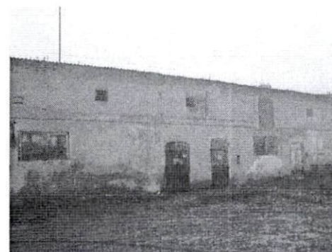
Chlew od strony południowo-zachodniej
