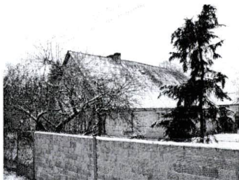
Dom od strony południowo-wschodniej
