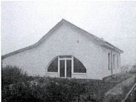
Szkoła od strony południowej
