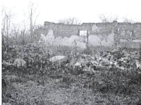
Chlew od strony południowo-zachodniej
