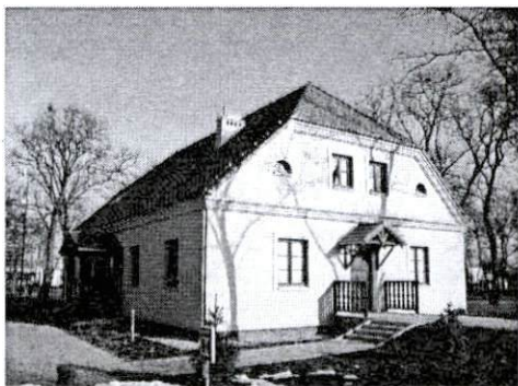
Dwór od strony południowo-zachodniej
