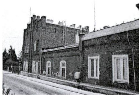
Gazownia od strony północno-zachodniej
