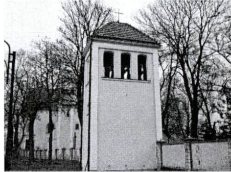
Dzwonnica od strony południowo-zachodniej
