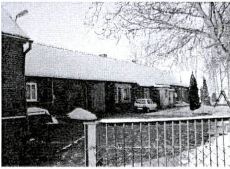
Budynki od strony południowo-wschodniej
