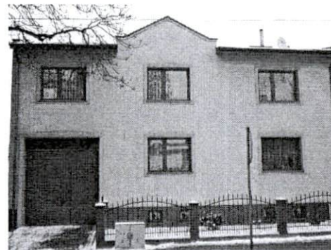
Dom od strony południowo-wschodniej
