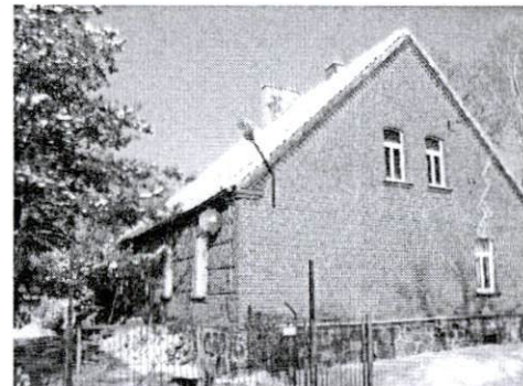
Budynki od strony południowej
