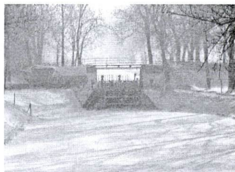
Śluza od strony północno-zachodniej
