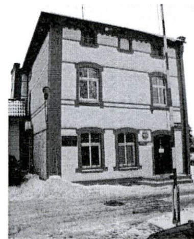
Komisariat od strony północno-wschodniej
