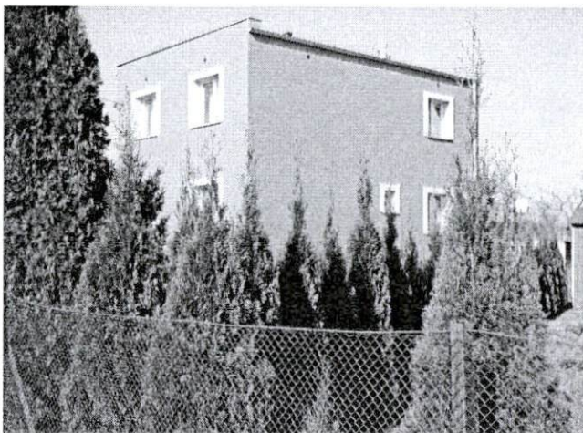
Szkoła od strony południowo-wschodniej
