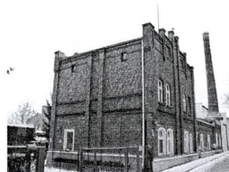
Gazownia od strony północno-wschodniej
