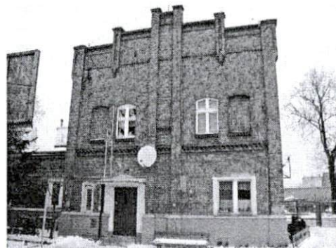
Gazownia od strony południowej
