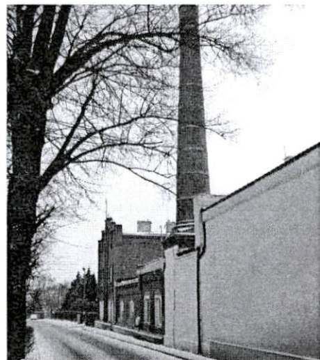
Gazownia od strony północno-zachodniej
