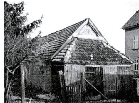
Budynek od strony południowo-zachodniej
