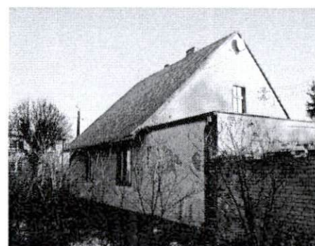
Dom od strony południowo-zachodniej
