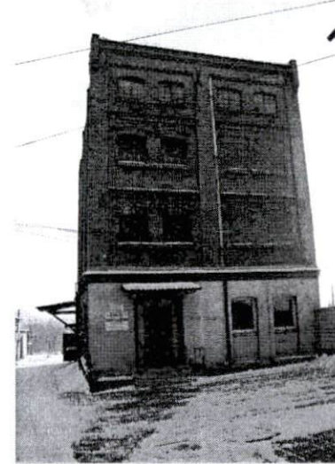
Magazyn od strony północno-zachodniej
