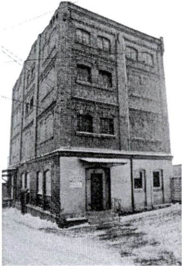
Magazyn od strony północno-zachodniej
