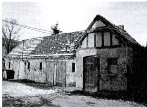
Budynek od strony wschodniej
