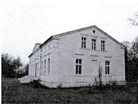
Dwór od strony południowo-wschodniej
