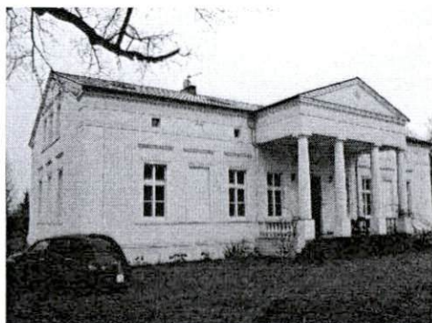
Dwór od strony północno-wschodniej
