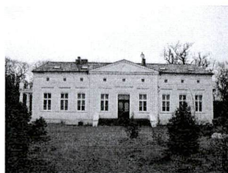
Dwór od strony południowo-zachodniej
