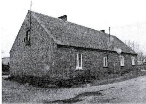
Czworak od strony południowo-wschodniej
