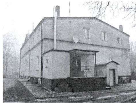
Dwór od strony południowo-zachodniej
