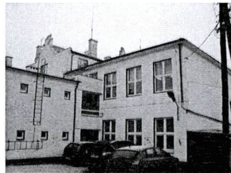
Szkoła od strony północno-zachodniej
