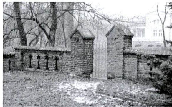
Ogrodzenie od strony północno-zachodniej
