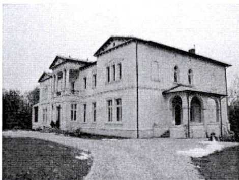
Pałac od strony północno-zachodniej
