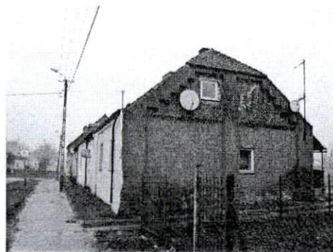
Dom od strony połudnowej
