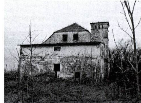
Kuźnia od strony południowej
