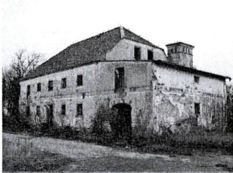
Kuźnia od strony południowo-zachodniej
